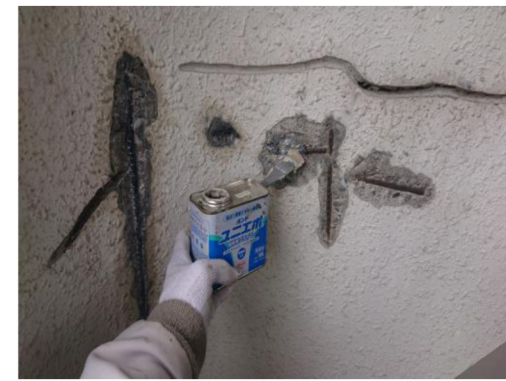
プライマー塗布
