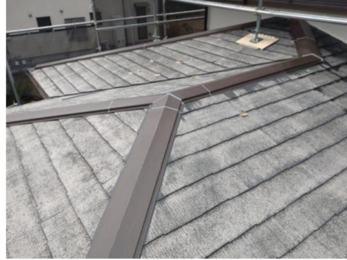
補修・洗浄完了後
