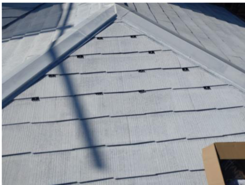
タスペーサー設置
